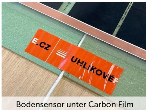
Bodensensor unter Carbon Film
