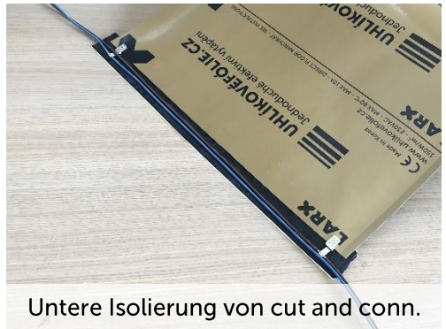
Einpressen der Stromkabel in den
